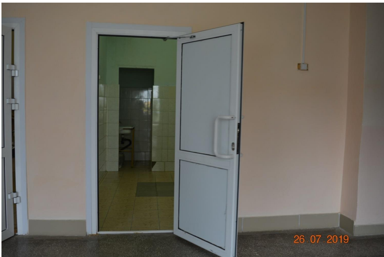
Фото 22. Вход в санузел
