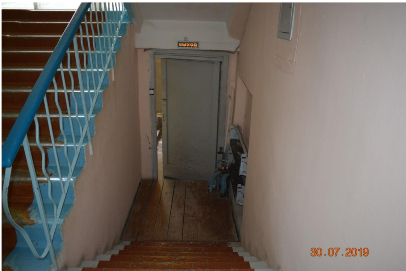
Фото 15. Эвакуационный выход с первого этажа
