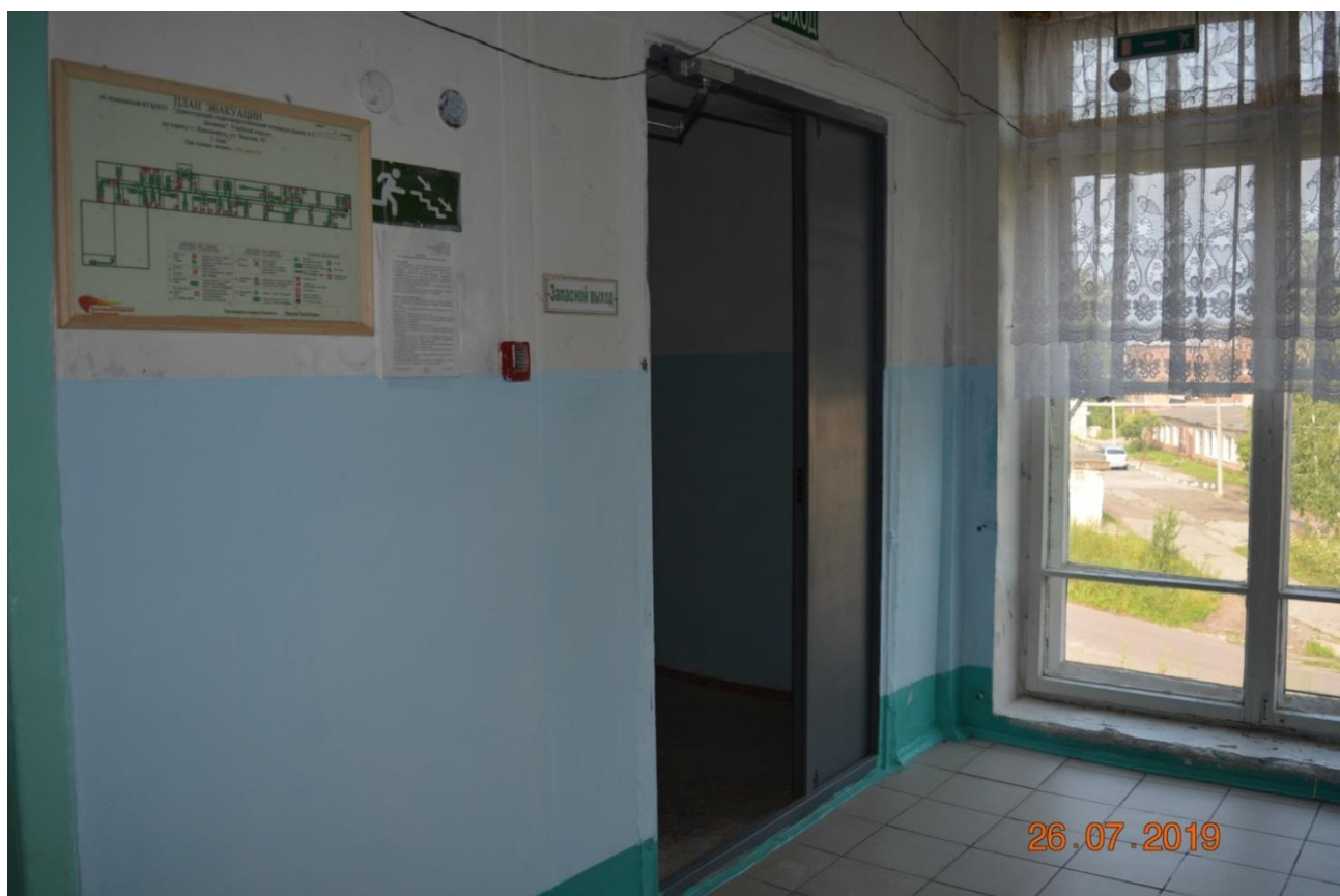
Фото 12. Эвакуационный выход со второго этажа
