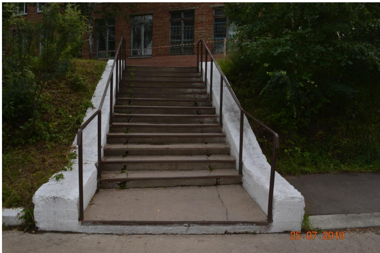
Фото 1. Вход на территорию
